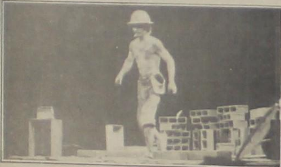
Robson Moreira em "Muro de Arrimo", ótimo espetáculo e ótima interpretação.
